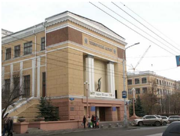
Рисунок 8 - Современный вид фасада главного корпуса
